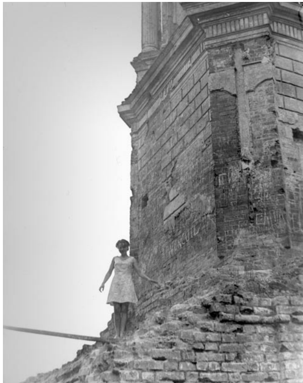
На месте обрушенного свода трапезной части храма
